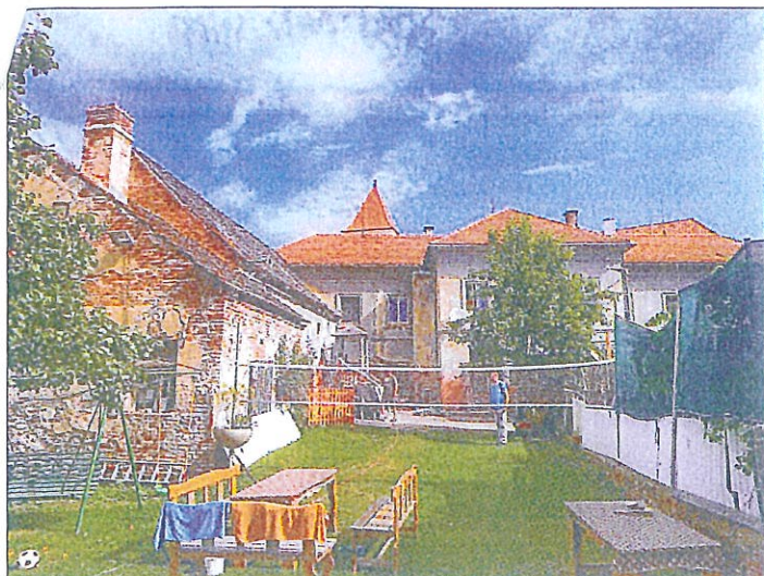
jižní pohled - fara, sýpka, kaplanka
