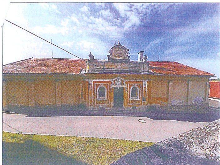
fara - severní průčelí
