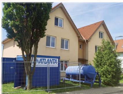
Opravy bytových domů Na Vinici
