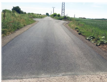
Oprava místních komunikací
