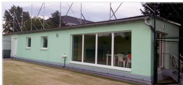
Stavební úpravy objektu šaten, navazujících komunikací a oplocení na tenisových kurtech v Hodonicích III. – V. 2017
