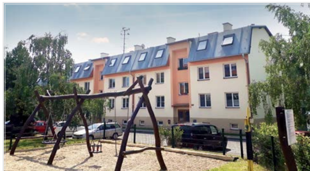
Oprava střešního pláště na bytových domech, Sídliště 3. Q 2015
