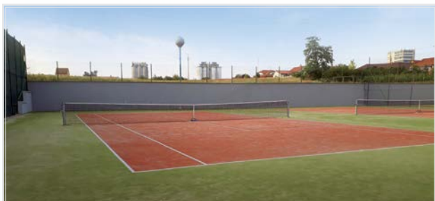
Oprava vnějšího tenisového kurtu V. – VI. 2016
