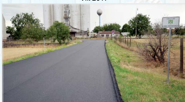
Místní komunikace „Ke Kobe“ VII. 2017
