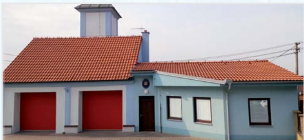
Oprava fasády hasičské zbrojnice V. – VII. 2016
